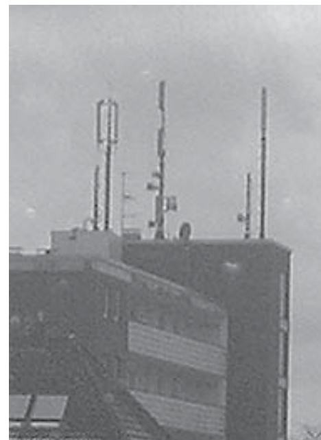
Foto oben: UMTS oder nicht? Hochhaus an der Werdener Straße
